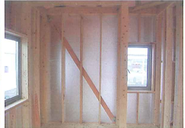
壁パネル内観 (サーモパネル)
